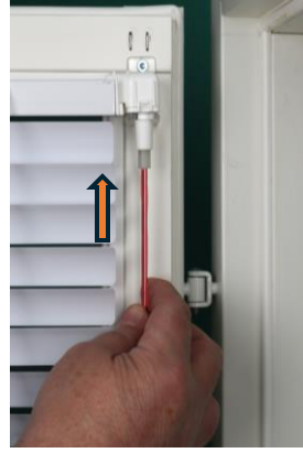
10. Työnnä akseli ylävaihteen holkkiin pohjaan asti.
