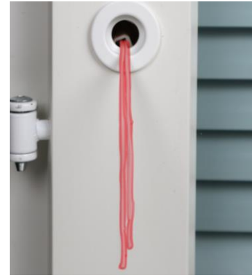
12. Pujota narut peiteholkin läpi ja paina se paikalleen.
