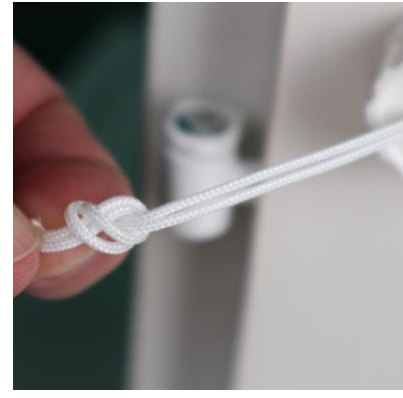
16. Varmista että kaihdin on alas laskettuna ja tee Naruihin solmu niin, että solmun ja nupin väliin jää noin 100 mm narua.
