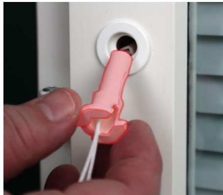
13. Laita ensin narut väännin holkin läpi ja sitten paina holkki voimakkaasti reiässä näkyvään neliötankoon pohjaan asti.
